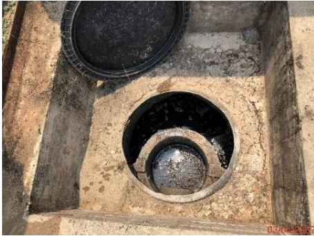
บ่อกักน้ำหลังผ่านระบบบำบัดน้ำเสียของอาคารที่พักผู้โดยสาร ชุดที่ 2
