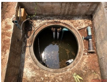
บ่อบำบัดน้ำก่อนเข้าระบบบำบัดน้ำเสียของอาคารที่พักผู้โดยสาร ชุดที่ 1
