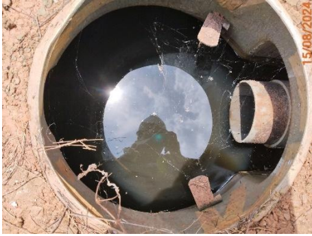
บ่อกักน้ำหลังผ่านระบบบำบัดน้ำเสียของอาคารที่พักผู้โดยสาร ชุดที่ 1
