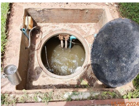
บ่อกักน้ำก่อนเข้าระบบบำบัดน้ำเสียของอาคารที่พักผู้โดยสาร ชุดที่ 1
