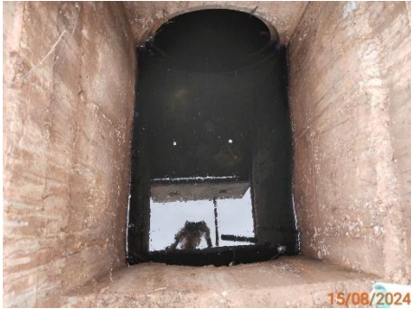
บ่อกักน้ำก่อนเข้าระบบบำบัดน้ำเสียของอาคารที่พักผู้โดยสาร ชุดที่ 2
